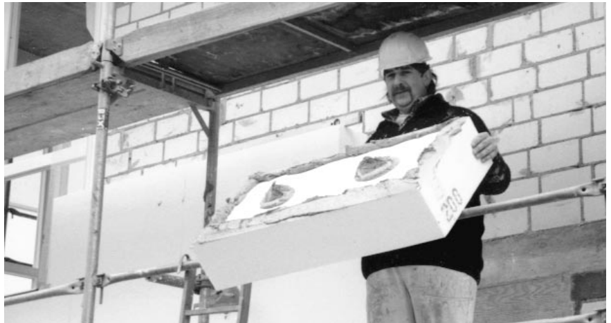
Entscheidend bei der Fassadendämmung ist die Sorgfalt und Fachkunde bei der Verarbeitung. Für Fugenabdichtung gibt es ausführliche Herstellervorschriften.
